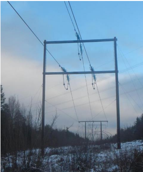
Figur 6. Bilden visar principutformningen för kompaktstolparna i den nya ledningen, med de tre faslinorna placerade mellan stolpbenen och i triangel i förhållande till varandra.
